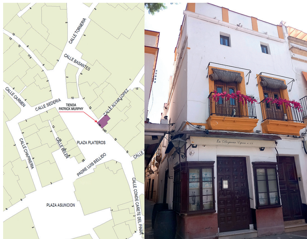
Figura 16. Ubicación de la tienda de mercader y vivienda de Patrick Murphy en la Plaza de Plateros, adyacente con la calle Lecheras, actual calle Alvar López, donde se ubicó su siguiente residencia.
